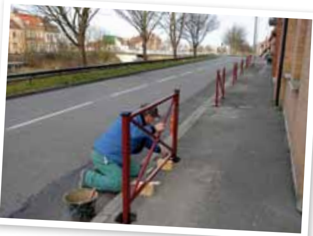
Sécurisation rue des Forts, des barrières adaptées qui accueilleront des jardinières suspendues qui remplaceront les vieux bacs en bois
