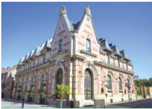
Rénovation complète de la façade et de l'intérieur de la mairie Gustave Fontaine.
